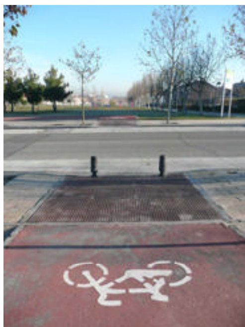
figura 6.12. falta de señalización en la vía rodada.
