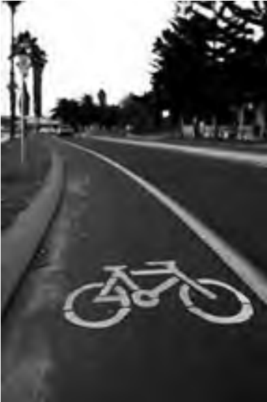
figura 7.13. carril en hormigón para ciclistas
