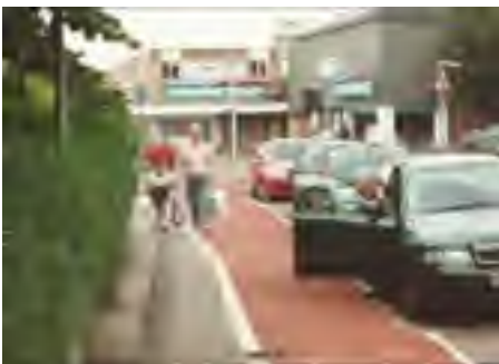
figura 7.7. carril bici realizado en acera excesivamente estrecha
