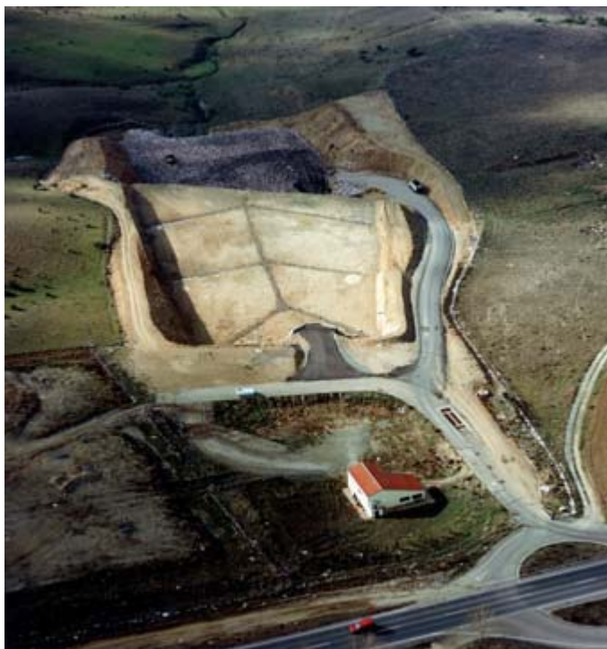
Vertedero de residuos sólidos urbanos en el que puede apreciarse la red de recogida de lixiviados (MMA)
