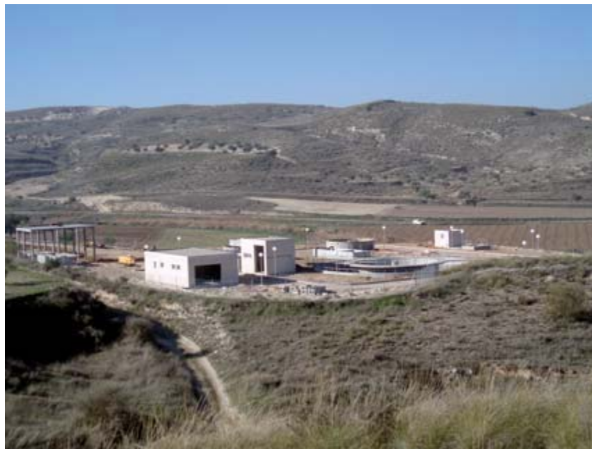
Obras de construcción de estación depuradora de aguas residuales urbanas de una aglomeración de menos de 10.000 habitantes equivalentes (Foto J. Ruza)
