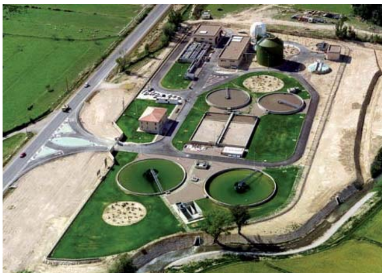
Estación depuradora de aguas residuales urbanas de Huesca (Foto MMA)
