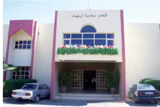
Edificio municipal de Targuist
